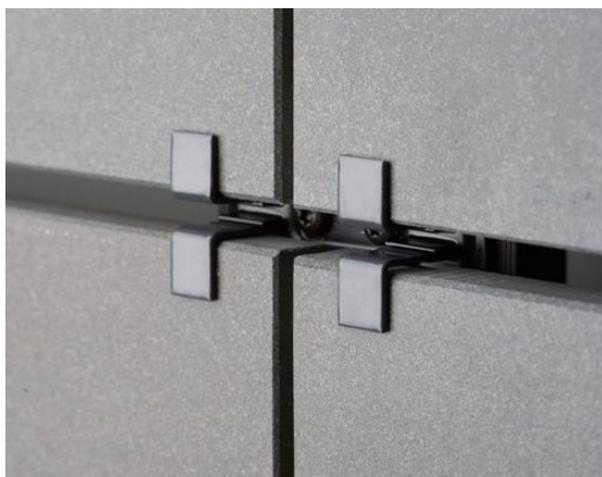
Según la normativa vigente es "obligatorio" complementar las fachadas pegadas con cemento cola mediante elementos de fijación mecánica (GRAPAS). Con ellas, evitaremos el desprendimiento de piezas cerámicas, losas, etc. como consecuencia del paso del tiempo y de los agentes atmosféricos al perder dicho cemento cola propiedades adhesivas.
